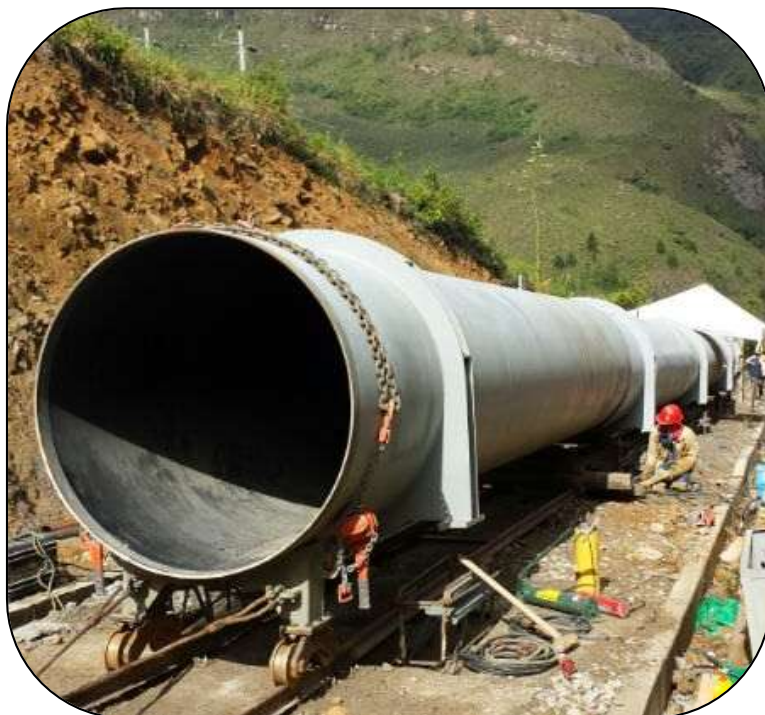
Fig. 3 Montaje de tubería por medio de carro fijo. (Rivera, 14/Mayo/2014)
