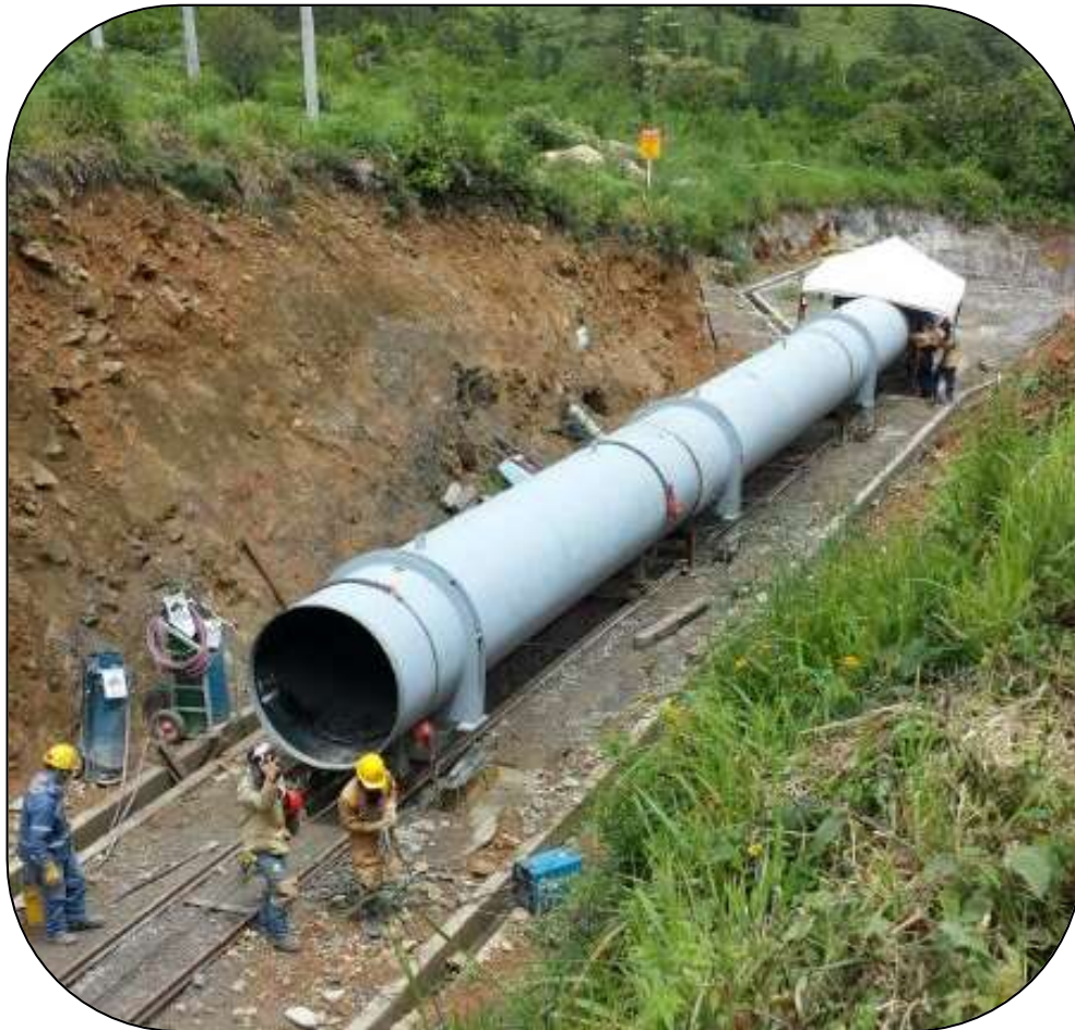
Fig. 1 Montaje tubería de presión. (Rivera, 14/Mayo/2014)
