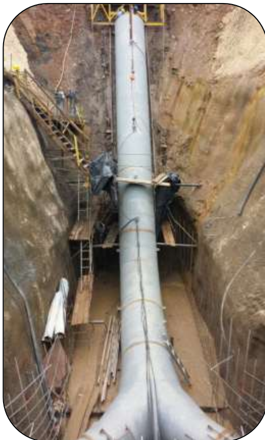
Fig. 2 Montaje tubería de descarga. (Rivera, 14/Mayo/2014)
