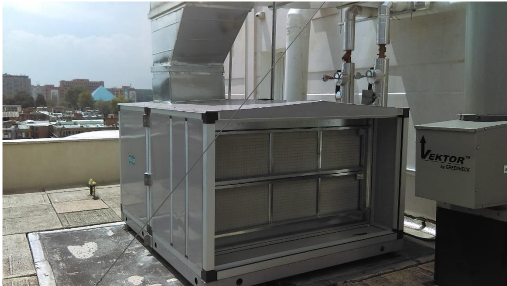
Figura 3. Unidad manejadora de aire (UMA)
