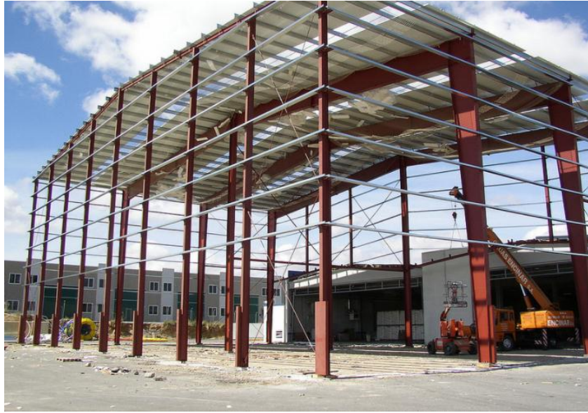
Imagen 1 5 . Correas y perlines en estructura metálica
