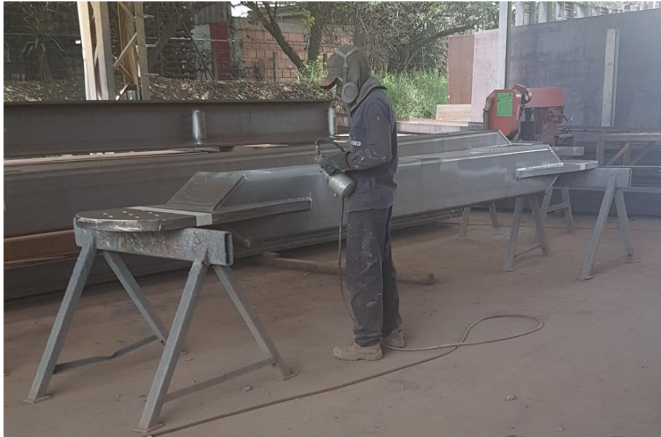
Imagen 2. Proceso de pintura en planta de fabricación de estructuras metálicas Tecmo. S.A
