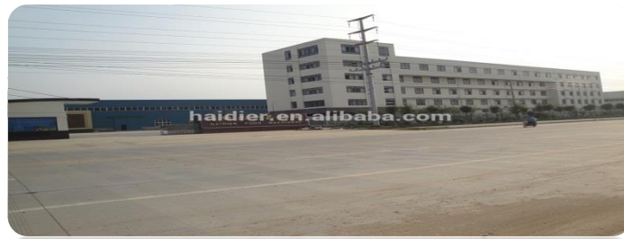
Figura 8 Instalaciones haidier co.
