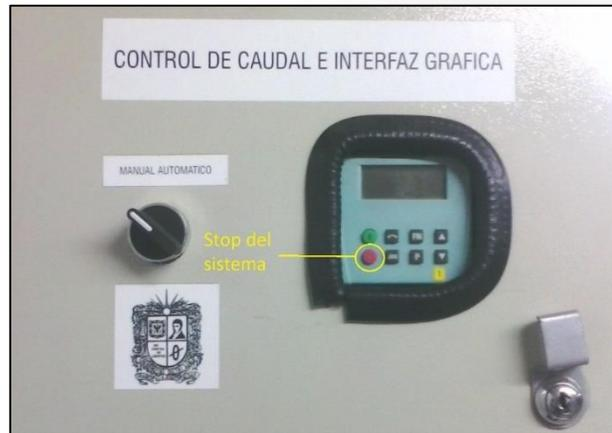
**Imagen 7. Apagado del sistema**
