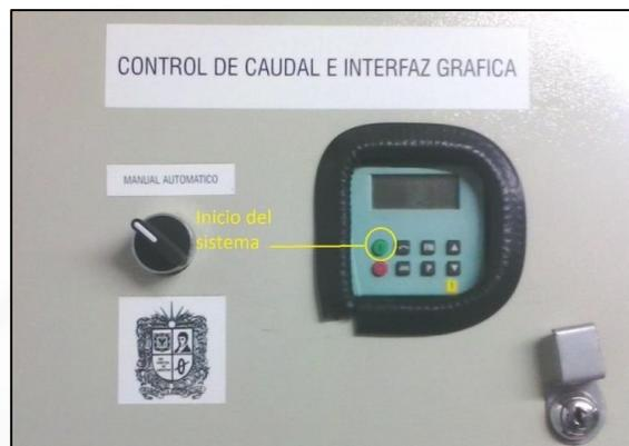
**Imagen 6. Encendido del sistema**
